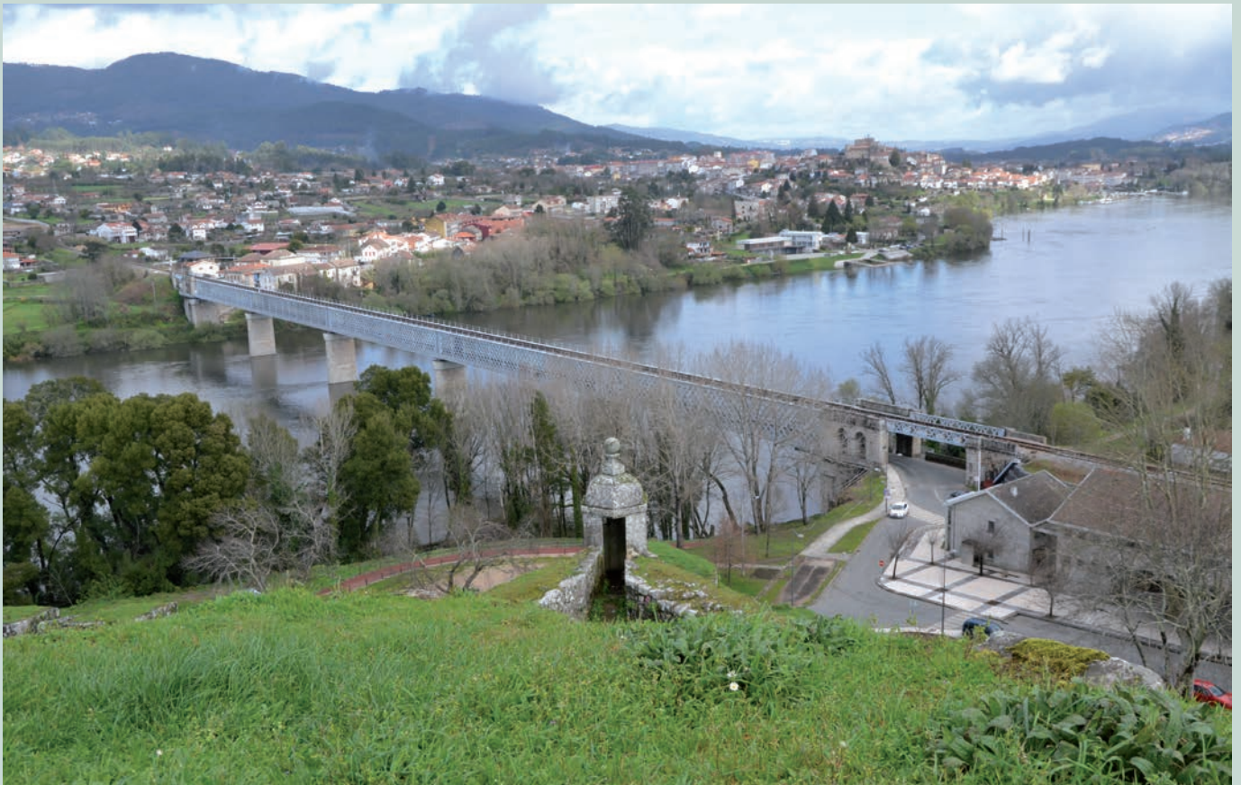
Ponte internacional sobre o rio Minho, entre Valença do Minho e Tui
